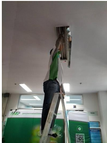
เปลี่ยนหลอดไฟฟ้าส่องสว่างบางจุดภายในอาคารอำนวยการ ยศสุข
