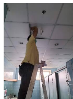
เปลี่ยนหลอดไฟไฮเบย์จาก 250 w เป็น 200 w
