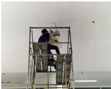
เปลี่ยนหลอดไฟไฮเบย์จาก 250 w เป็น 200 w
