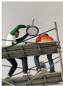
เปลี่ยนหลอดไฟไฮเบย์จาก 250 w เป็น 200 w
