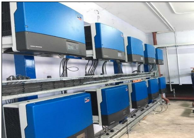
การติดตั้งพลังงานไฟฟ้าทดแทนไฟฟ้าพลังงานแสงอาทิตย์หลังคา
